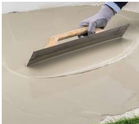
A Novoplan 220 alkalmazása
