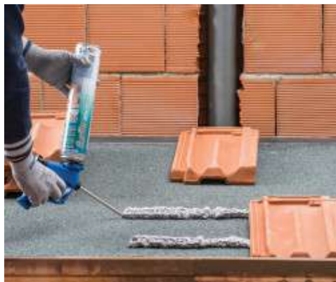
Tetőcserepek ragasztása cseppekben alkalmazott termékkel
