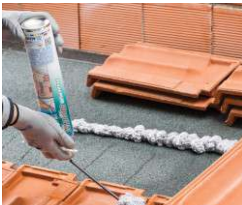
Tetőcserepek ragasztása foltokban alkalmazott termékkel
