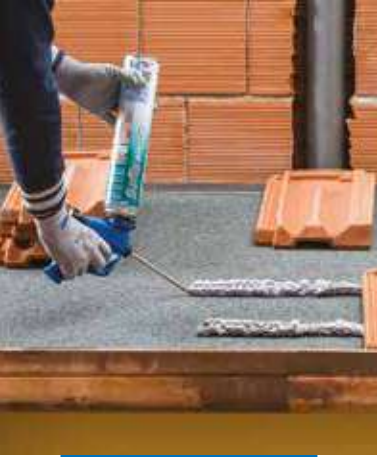
Tetőcserepek ragasztása cseppekben alkalmazott termékkel
