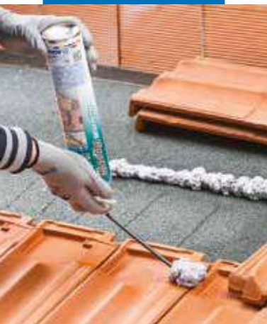
Tetőcserepek ragasztása foltokban alkalmazott termékkel
