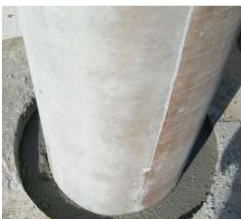
Előregyártott pillér rögzítése
