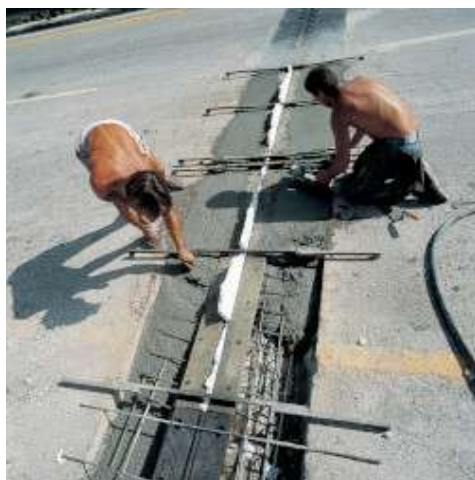
Autópályahíd merev csatlakozásának javítása Mapefill-lel
