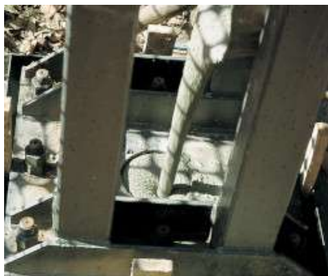
Fém állványzat kihorgonyzása Mapefill-lel
