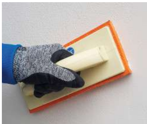
PoroMap Finitura Civile felületképzése szivacs simítóval
