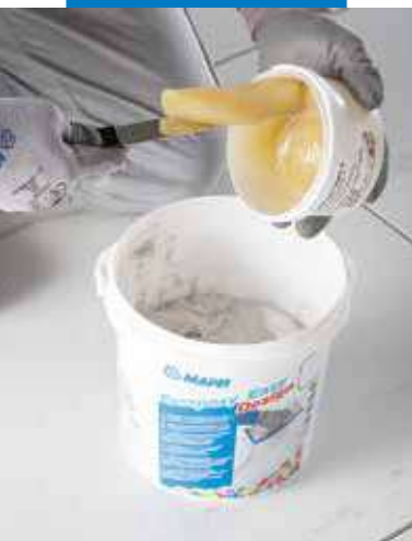
Öntse az edzőt (B komponens) az A komponens edényébe
