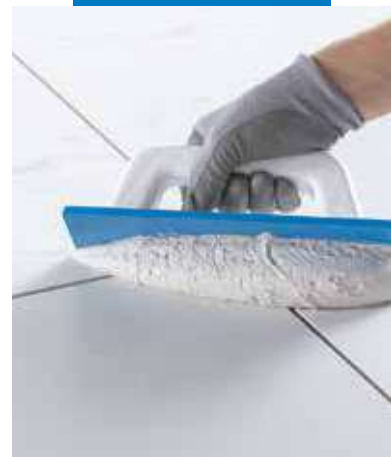
A Kerapoxy Easy Design-t Mapei simítóval terítse el
