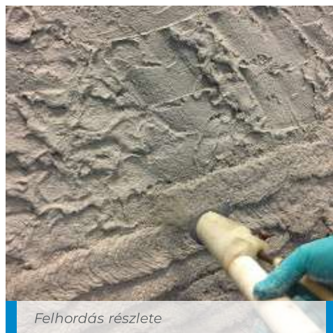
A Poromap Szárítóvakolat felhordása vakológéppel
