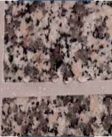
Meglévő kültéri természetes kő burkolat hézagkitöltése
