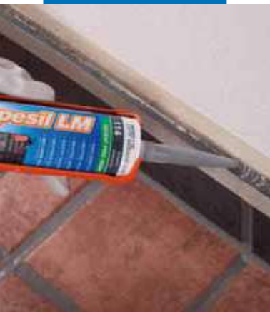
Beltéri természetes kő burkolat hézagkitöltése
