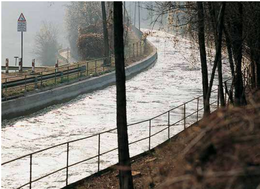
Bertini vízerőmű üzemvíz csatornája - Como, Olaszország; a felületeket Planiseal 88-cal kezelték
