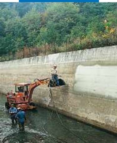
Planiseal 88 felhordása szórópisztollyal vízerőmű üzemvíz csatornájában
