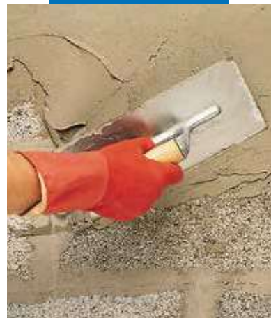
Planiseal 88 felhordása simítóval
