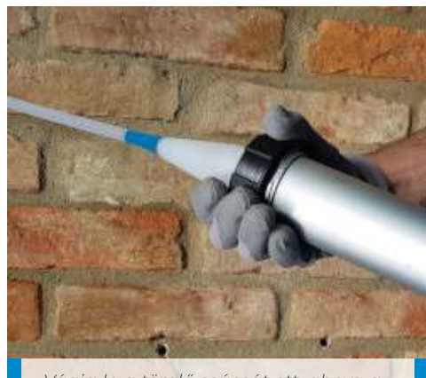
Vágja le a tömlő csúcsát ott, ahova a gyűrű fel lesz csavarozva
