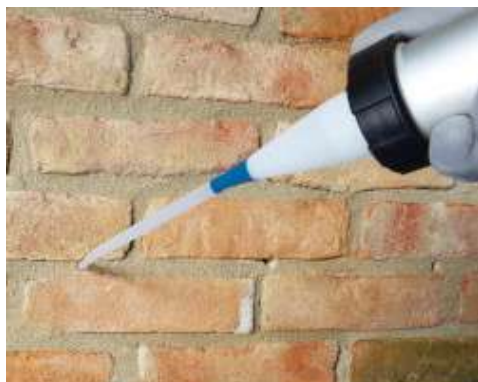
Csavarja fel a gyűrűt a pisztolyra, amely az injektálószerszámot rögzíti a helyén
