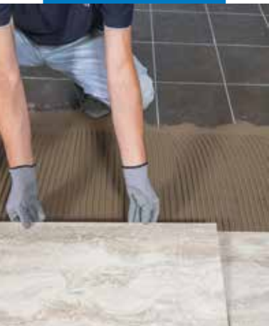
Kő hatású padlóburkoló lapok fektetése meglévő padlóburkolatra
