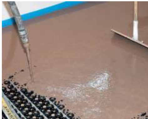
A Novoplan Maxi szivattyúzása és kiegyenlítése
