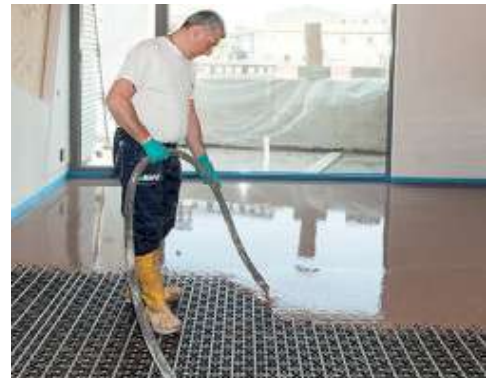
A keverék terítése a kompakt fűtési rendszer teljes beágyazása érdekében
