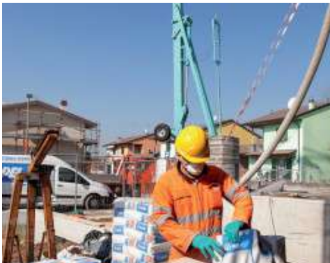
A Novoplan Maxi előkészítése és szivattyúzása folyamatos keverésű szivattyúval
