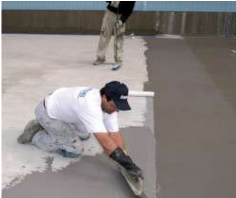
Úszómedence vízszigetelése Mapelastic-kal
