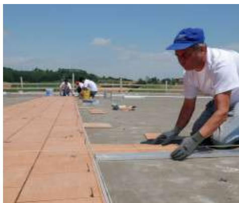
Kerámia burkolólapok fektetése Kerabond + Isolastic keverékkel
