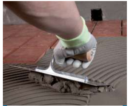
Granirapid felhordása Mapelastic-kal vízszigetelt teraszra
