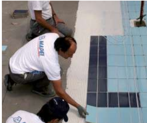
Kerámia burkolólapok fektetése Mapelastic-ra úszómedencében
