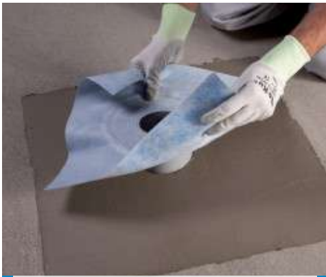
Drain Vertical beépítése Mapelastic-ra
