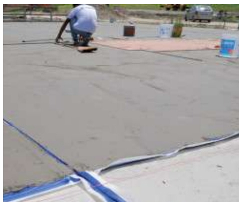
Esztrichek vízszigetelése Mapelastic -kal és Mapeband -dal
