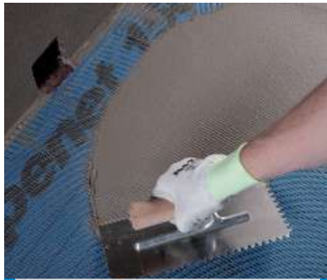
Mapelastic felhordása Mapenet 150-re
