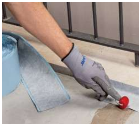
Mapeband SA bedolgozása élekhez
