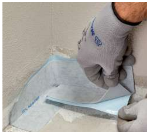
Mapeband SA bedolgozása sarokba
