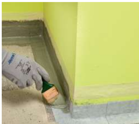
Mapeband SA bedolgozása esztrichre
