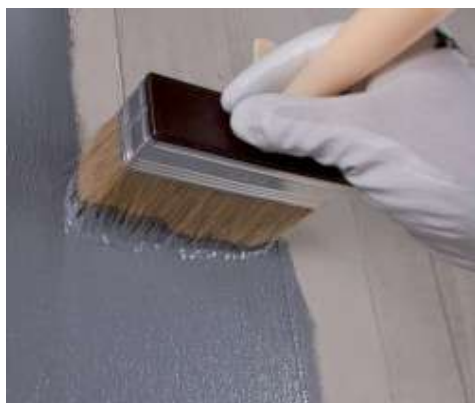
Eco Prim Grip Plus felhordása betonra ecsettel
