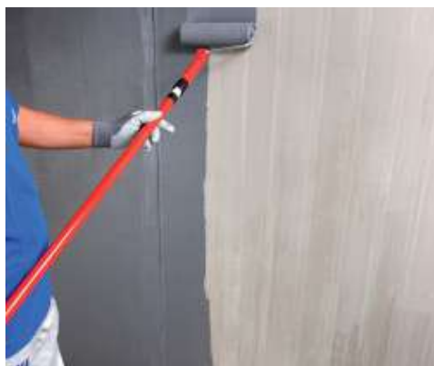
Eco Prim Grip Plus felhordása betonra hengerrel
